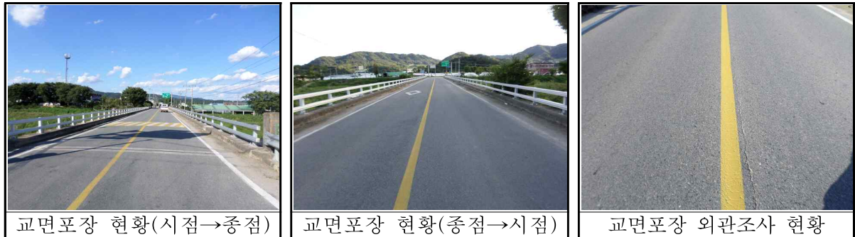
【그림 3.3】 교면포장 현황
