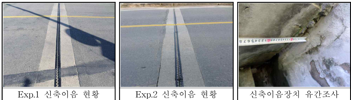
【그림 3.22】 신축이음장치 현황 및 외관조사
