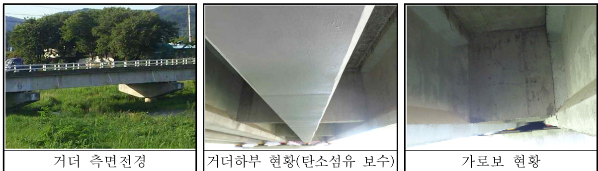
【그림 3.12】 거더(PSC BEAM) 현황
