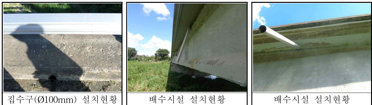
【그림 3.26】 배수시설 현황
