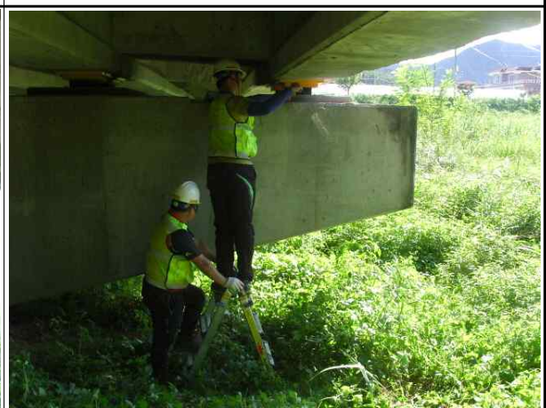
교량하부 외관조사(2인 1조)
